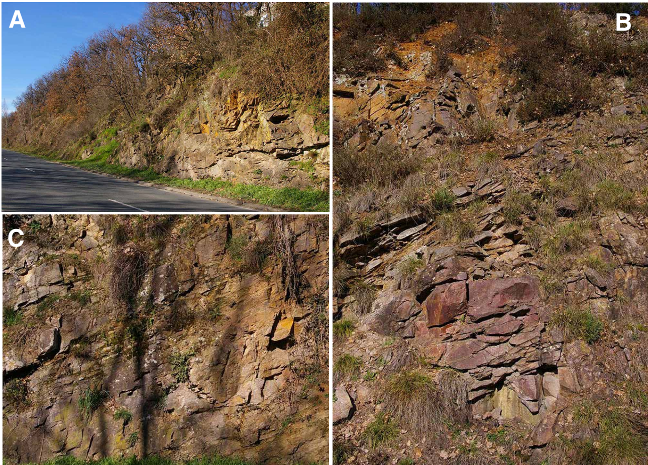
Fig. 4 – Les gneiss leptynitiques du Complexe leptyno-amphibolique, à l’ouest de Rieucan (ouest de Réalmont). A. long affleurement le long du talus de la RD 631 ; B. gneiss foncés, massifs, de composition basique; C. pendage de la foliation en direction de l’ouest.
